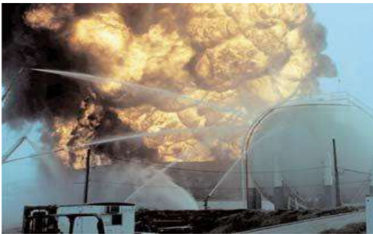
Refrigeración esfera GLP cercana a tanque incendiado
