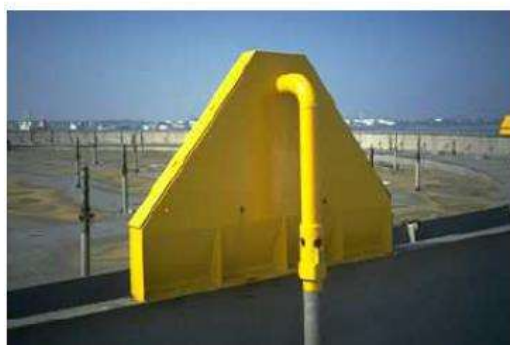
Ejemplos de deflectores en tanques de techo flotante:
