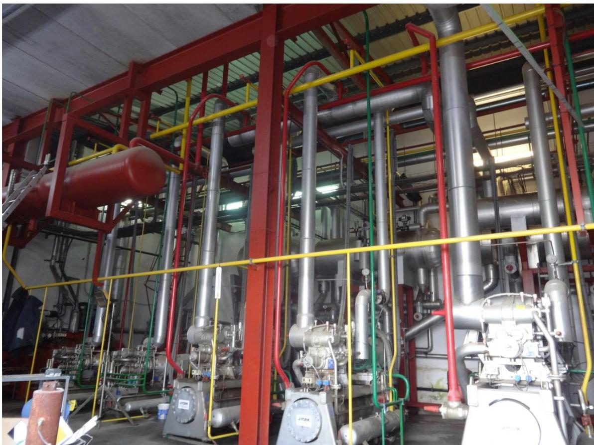
Sala de máquinas con cinco circuitos de refrigeración para cinco zonas con diferentes temperaturas. Foto: C. Artero
