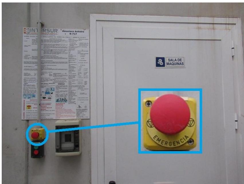
Pulsador de emergencia fuera de la sala de máquinas que para todo el sistema de refrigeración. Foto: C. Artero
