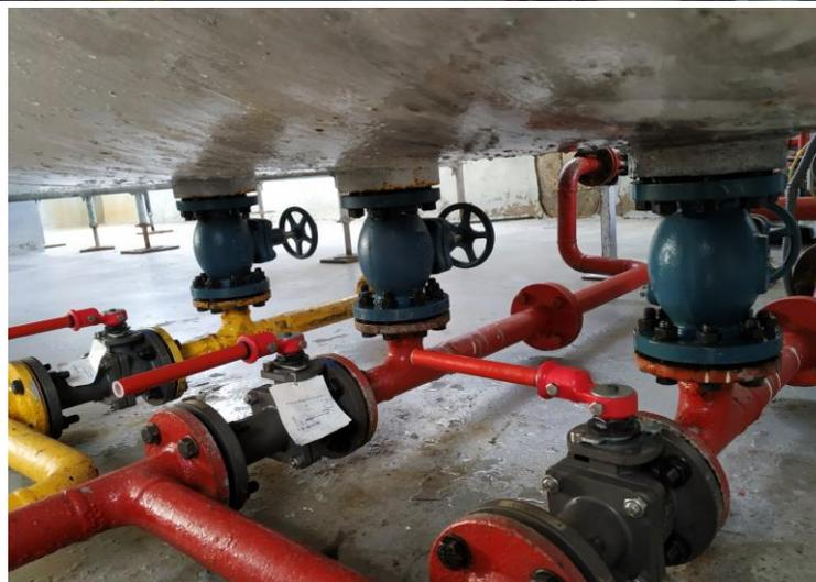
1. Recipiente a presión de amoniaco en interior de cubeto, realizando mantenimiento en las válvulas de seguridad.
