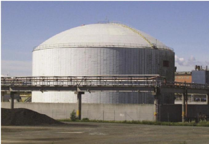
Tanque atmosférico refrigerado, de pared interior y exterior de acero, con techos separados.
