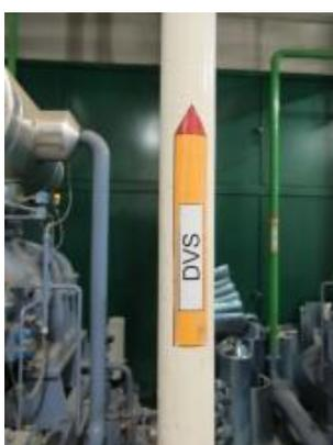
Identificación de una tubería de descarga de una válvula de seguridad. Foto. C.Artero
