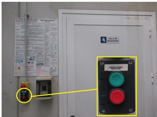
Botones de arranque y parada de la ventilación forzada en el exterior de la sala. Foto: C. Artero
