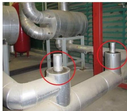
Detalle de dos válvulas de amoníaco líquido a la entrada de los evaporadores
