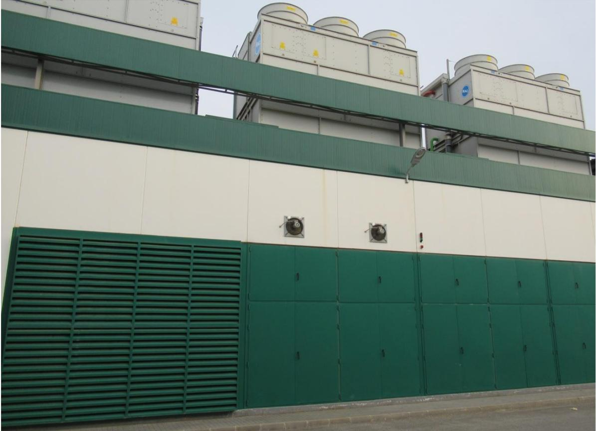
Vista lateral de una sala de máquinas. Se observan las rejillas para la ventilación natural y dos ventiladores para la ventilación forzada. Y arriba tres condensadores evaporativos. Foto: C. Artero
