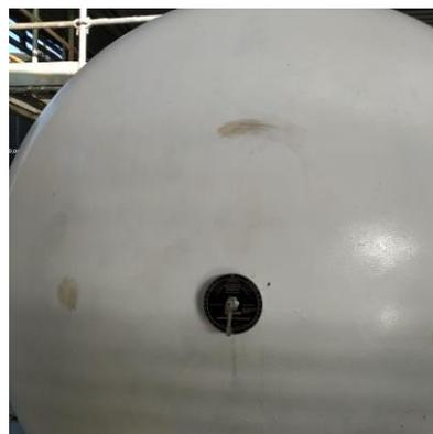
Indicador de nivel mediante galga rotativa en recipiente a presión.
