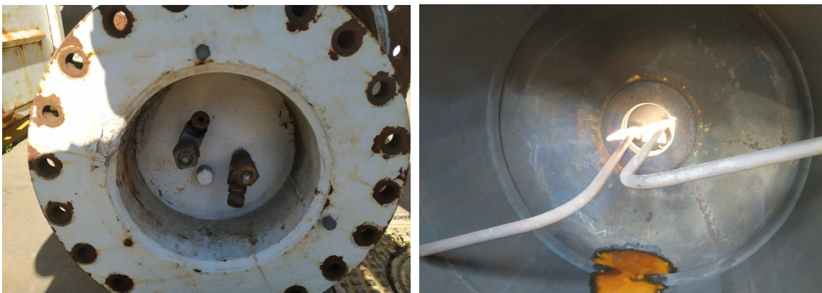
Válvulas y tubos buzo interiores del bidón a presión de cloro Fuente.: M.Albaladejo
