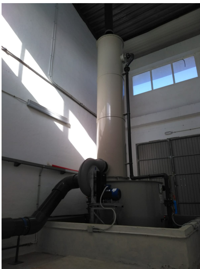
Scrubber para el lavado de gases.
