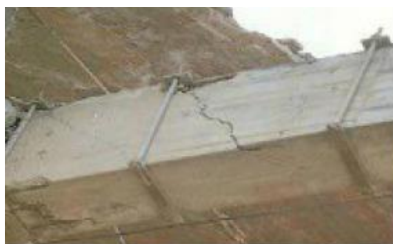
Fuente: IVE por esfuerzo a torsión
