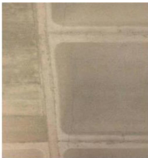
Fuente: IVE Retracción térmica en forjado reticular
