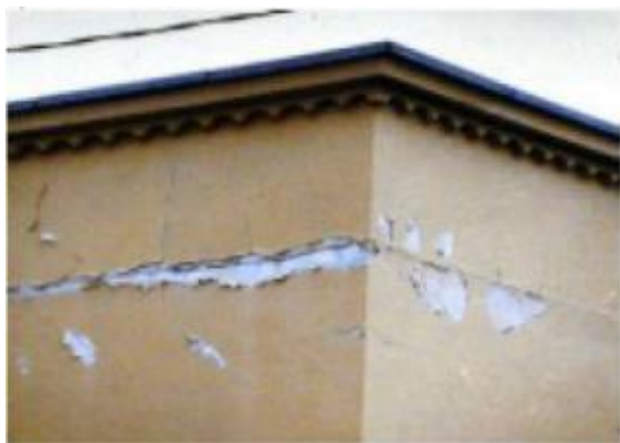
Fuente: IVE Lesión en fachadas por falta de resistencia a flexión
