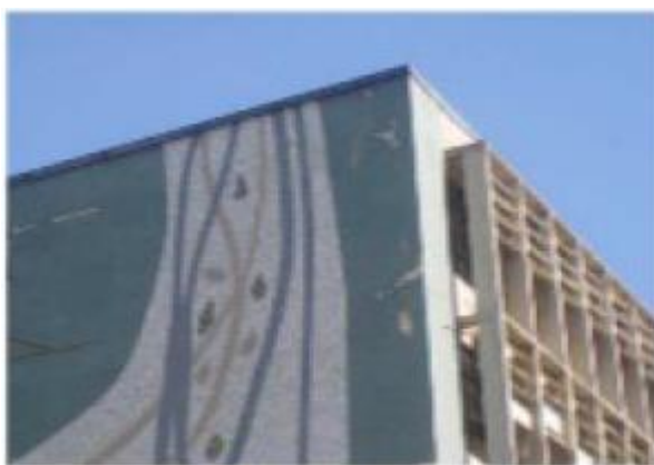
Fuente: IVE Fisuras horizontales por deformación de forjado de cubierta
