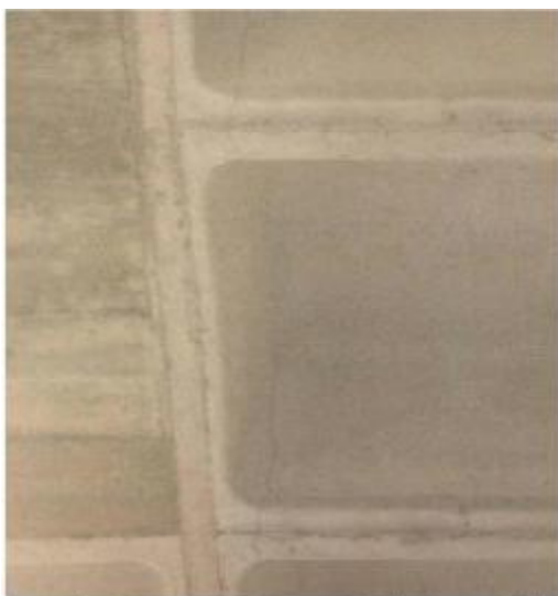
Font: IVE Retracció tèrmica en forjat reticular
