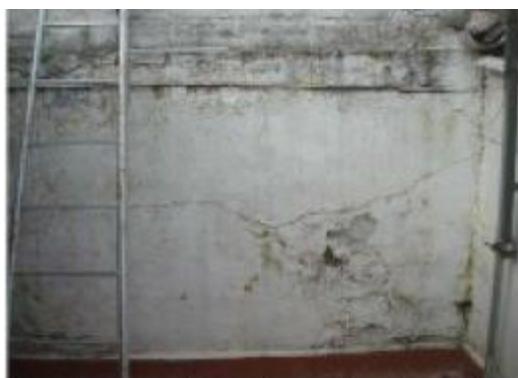
Font: IVE Fissures horitzontals per falta de resistència a flexió
