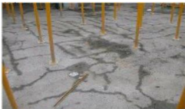
Font: IVE Retracció hidràulica en forjat reticular i unidireccional
