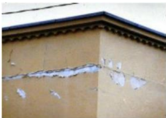
Font: IVE Lesió en façanes per falta de resistència a flexió.
